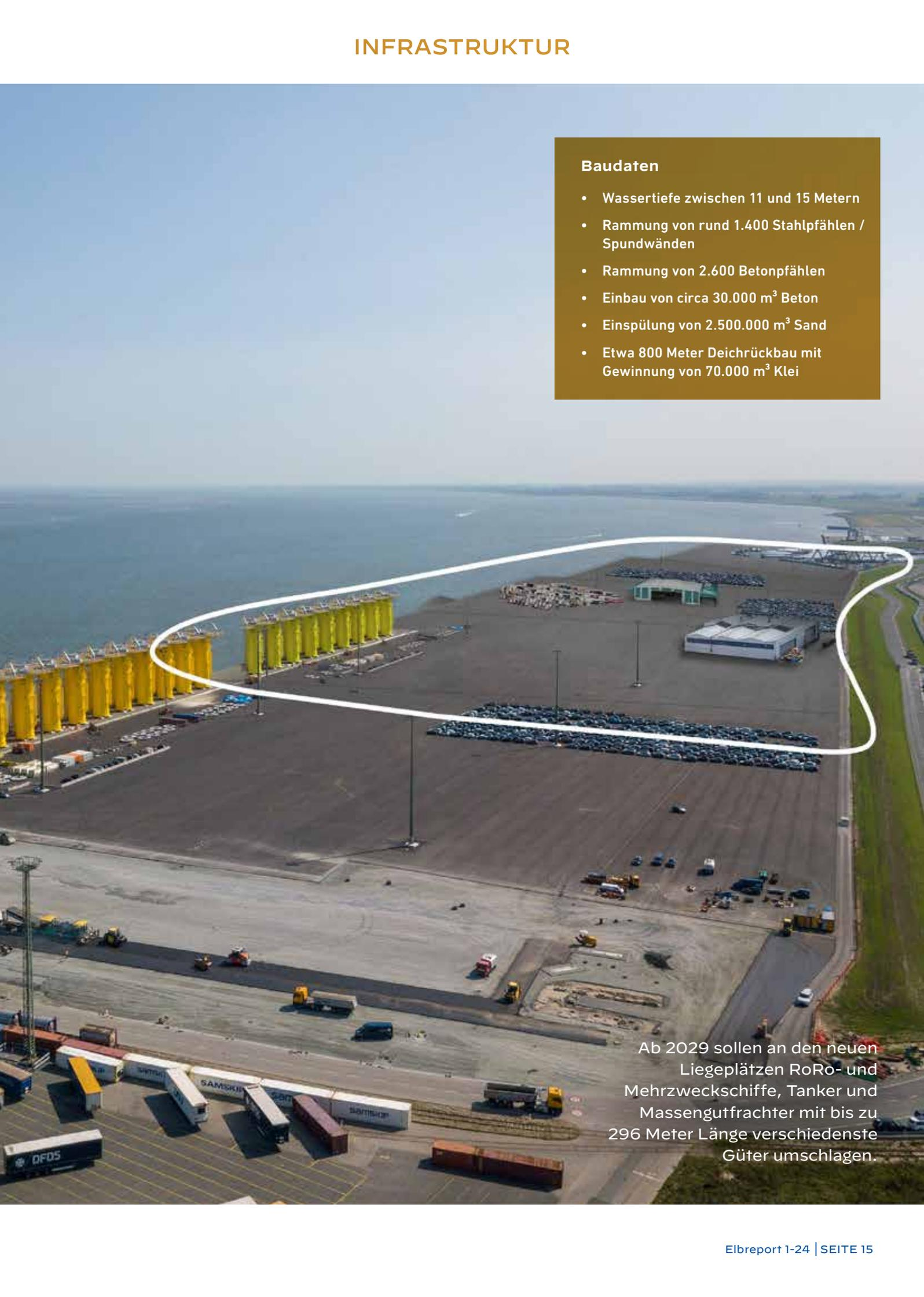
Ab 2029 sollen an den neuen Liegeplätzen RoRo- und Mehrzweckschiffe, Tanker und Massengutfrachter mit bis zu 296 Meter Länge verschiedenste Güter umschlagen.
